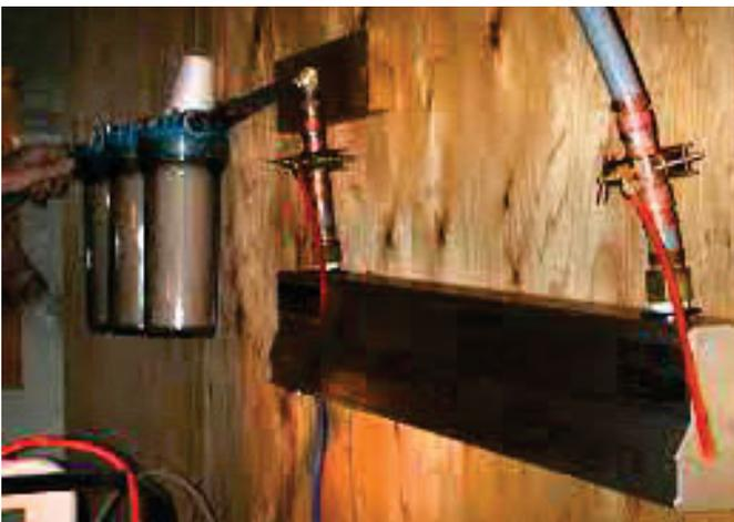
Figure 9: Appareil de traitement UV et préfiltre à cartouche solidement fixés au mur
